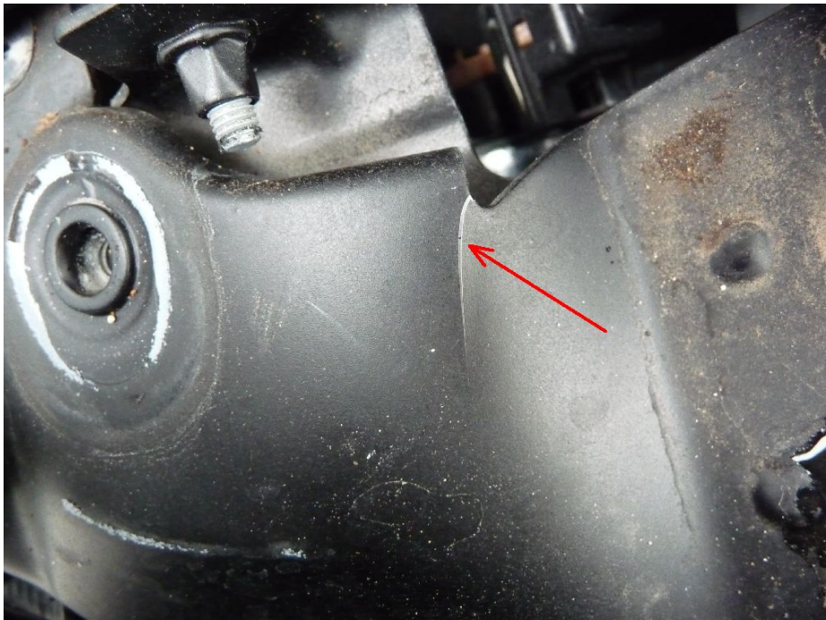
Bild 12: Frontmodul v.r. verformt, Lack gerissen
